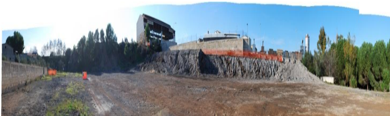
Figura_2. Interventi di bonifica tra il 2015 ed il 2016 di lama castello
